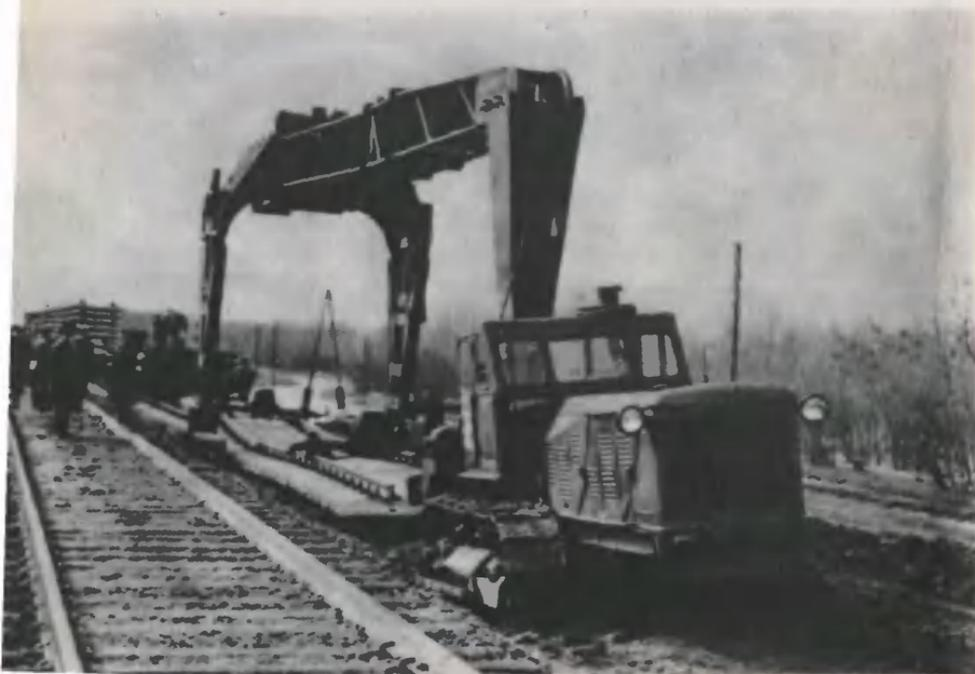
На нижнем снимке — порталный путеукладчик. Трактор ведет по насыпи ферму на двух гусеничных тележках, на которой установлены грузовые лебедки. Полуавтоматические захваты опускают на землю звенья одно за другим. Работой руководит оператор за переносным кнопочным пультом управления.
